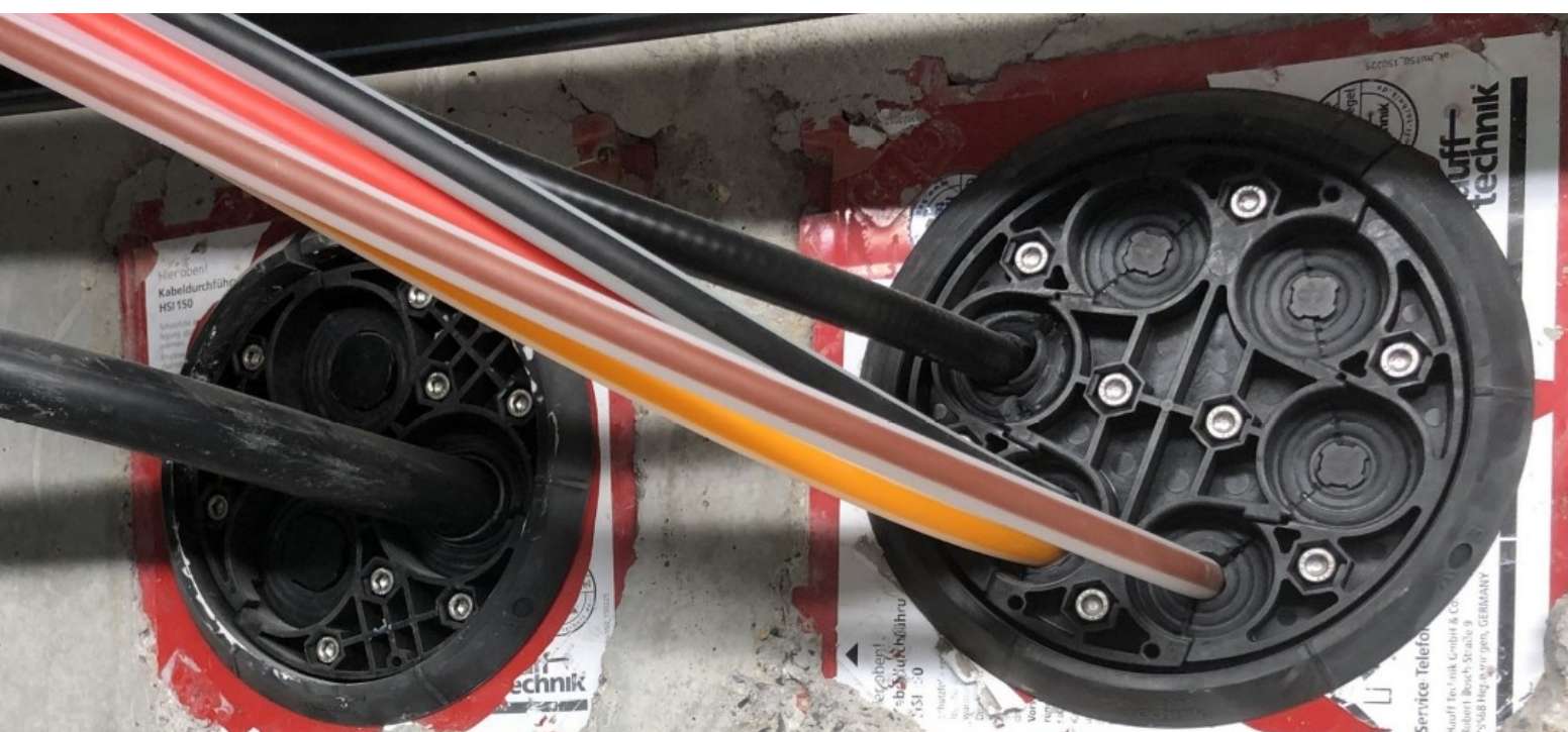
▲ HRK-SSG-druk dichtingen bevatten supersegmentringtechniek en kunststof persplaten voor een gas- en waterdichte afsluiting
